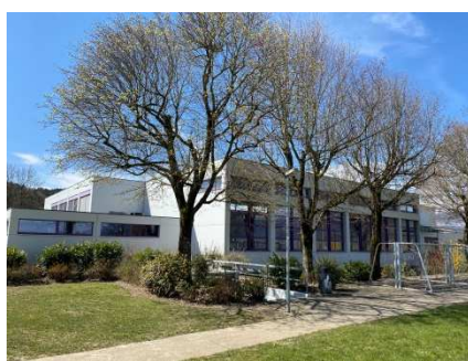
Mehrzweckanlage (Turnhallen Ostfassade)
