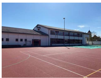
Mehrzweckanlage (Turnhalle Nordfassade)
