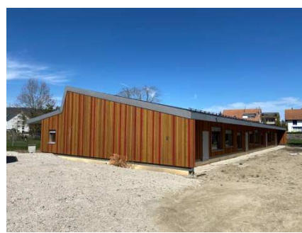
Neubau Dreifachkindergarten (Westfassade)
