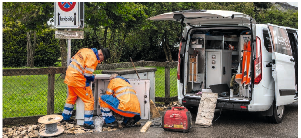
Das Team der Signal AG setzt den Steuerungskasten.
