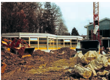
Neubau der Bibliothek Höfli
