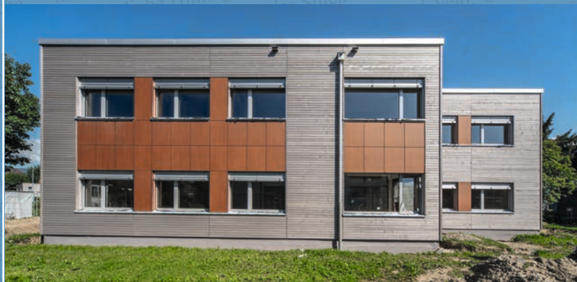
Studen: Neubau Schulraumprovisorium – termingerecht auf den Schulbeginn Sommer 2020/2021 bezugsbereit
