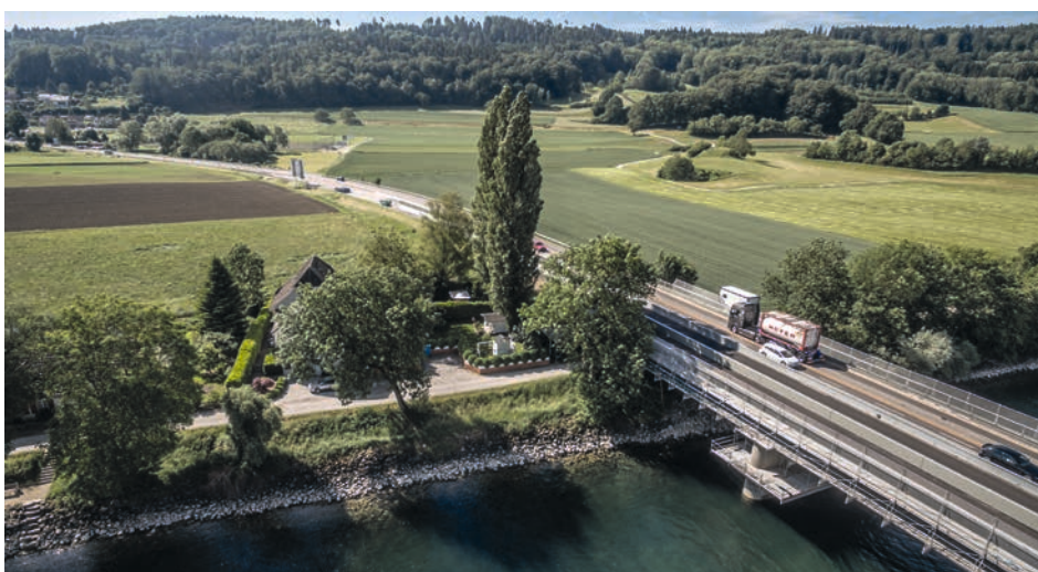
Sanierung Brücke Nidau-Büren-Kanal (Blickrichtung Lyss)
