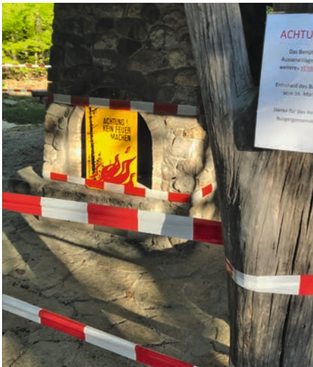
Beim Fortsthaus der Burger: Abgesperrt
