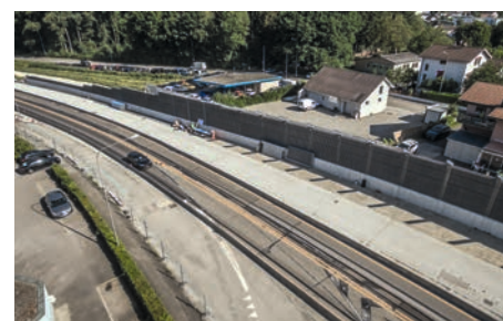
Lärmschutzwände nach Expokreisel (Blickrichtung Biel)
