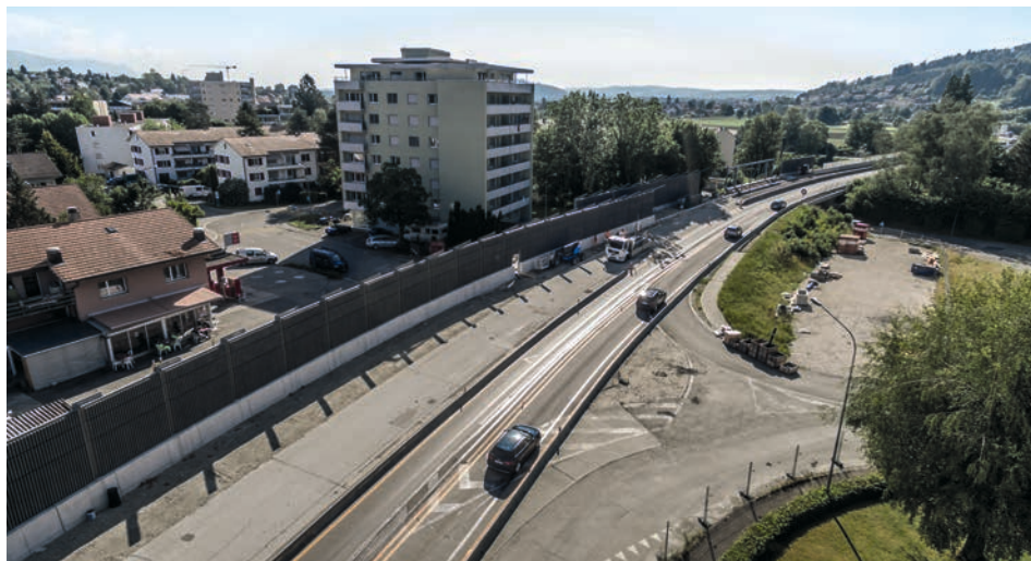
Lärmschutzwände nach Expokreisel (Blickrichtung Lyss)
