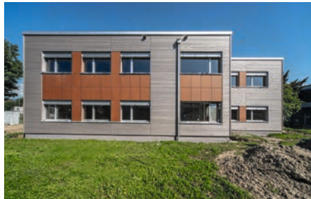
Ansicht der Hauptfassaden. Als gestalterisches Element wurden im Bereich der Fenster eingefärbte Vollkernplatten verwendet.
