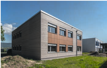
Ansicht der Hauptfassaden. Als gestalterisches Element wurden im Bereich der Fenster eingefärbte Vollkernplatten verwendet.
