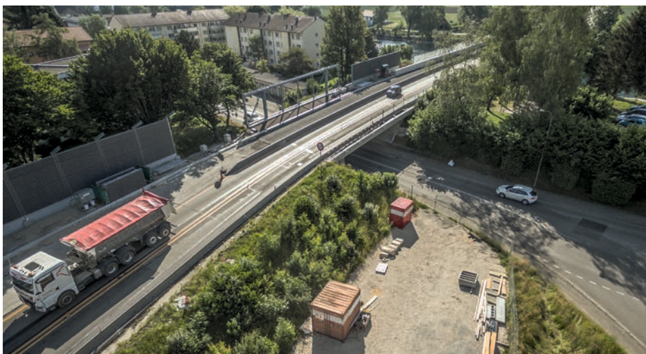
Sanierte Unterführung Neubrückstrasse
