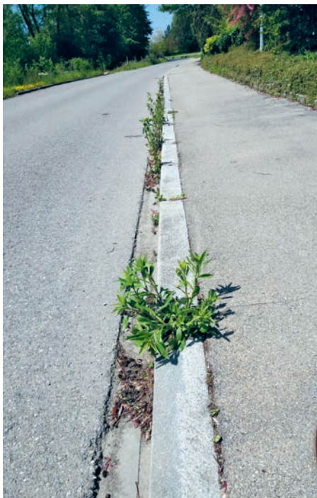
Strassenränder nach Unkrautbefall – damit muss beim Verzicht auf Einsatz von Herbiziden vermehrt gerechnet werden.
