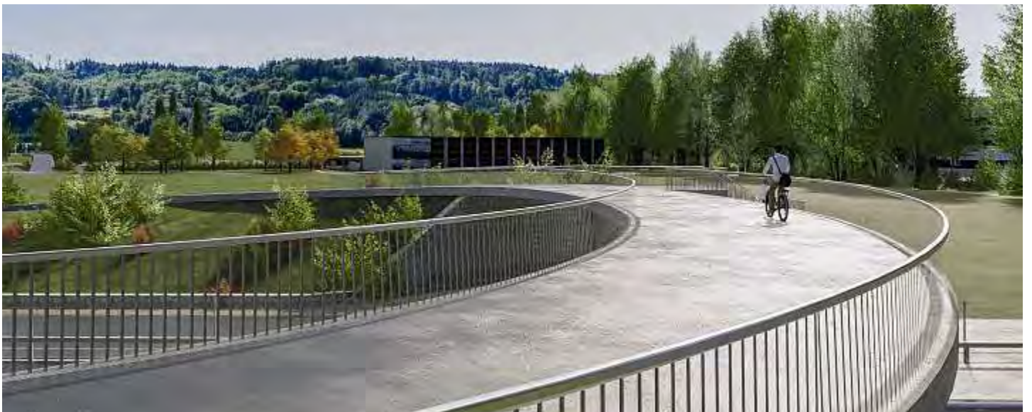
Velo- und Fussgängerbrücke über A6 (im Hintergrund die Mehrzweckanlage).
