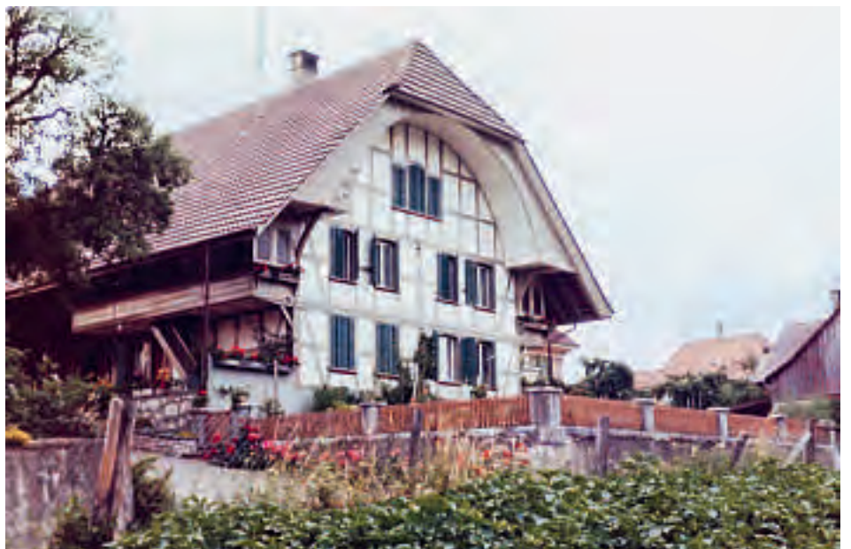
Das stolze Bauernhaus von «Hämmis» an der Orpundstrasse.
