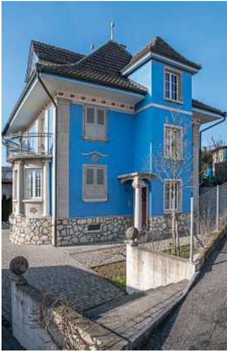
Das «Kämpf-Haus» an der Bielstrasse 82, heute wunderschön renoviert.
